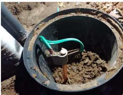
Figura B – Exemplo de uso indevido de conector cunha em alumínio.
